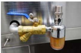
Kies voor een waterslang Ø 21 mm, voor de aansluiting van de watertoevoer. De waterdruk zou 1-7 kg/cm<sup>2</sup> moeten bedragen.
